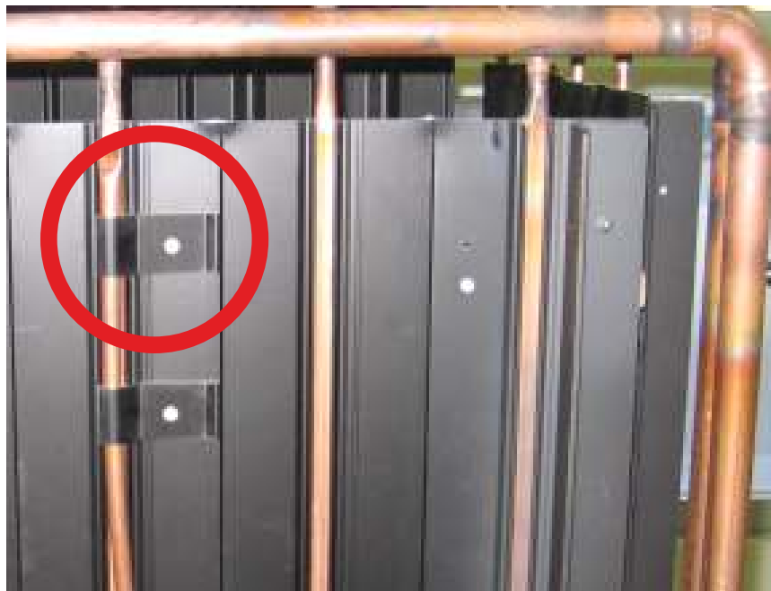
Abbildung: Montagevorschlag Absorberfühler
